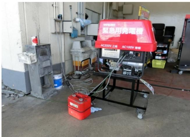
SSの配電盤につないだ緊急用発電機
