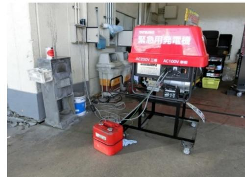
SSの配電盤につないだ緊急用発電機
