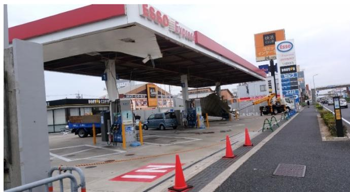
強風によりキャピアーの天井が落下したSS（2018.9.6撮影）
