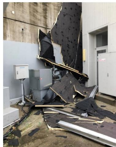
強風により、SS内にある建物の側壁が崩落したSS（2018.9.4撮影）
