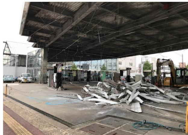
台風による強風によりキャピアーの天井が落下したSS（2018.9.6撮影）
