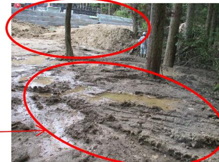
流出土砂により埋没した流路 (土砂は一部除去済)
