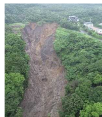
死者・行方不明者28名、住宅被害98棟
