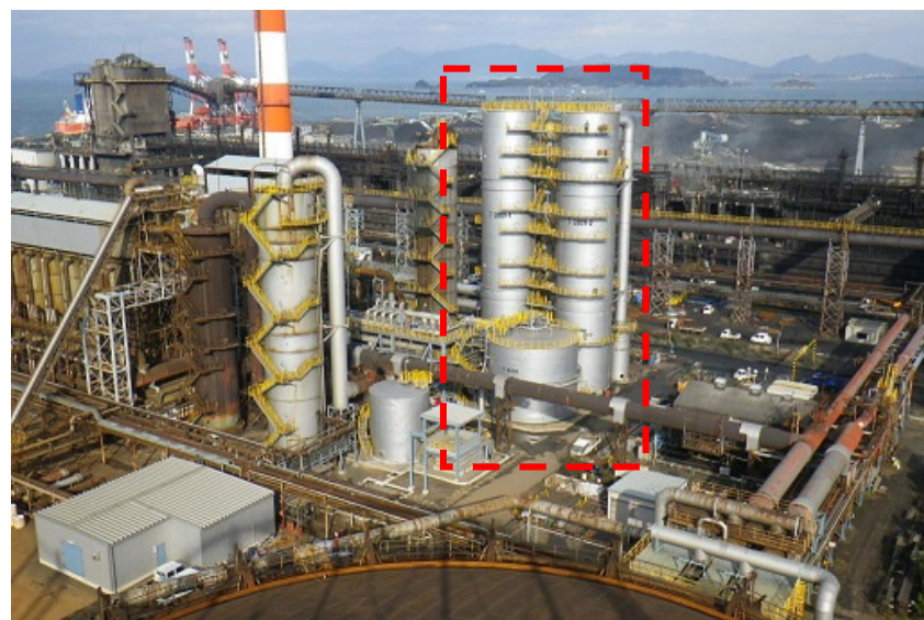
コークス炉に設置された脱硫装置 (日本コークス工業 北九州事業所)
