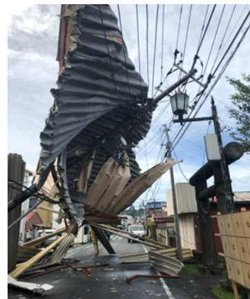
飛来物による設備損傷
