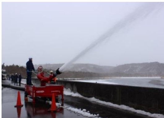
可搬型放水砲
