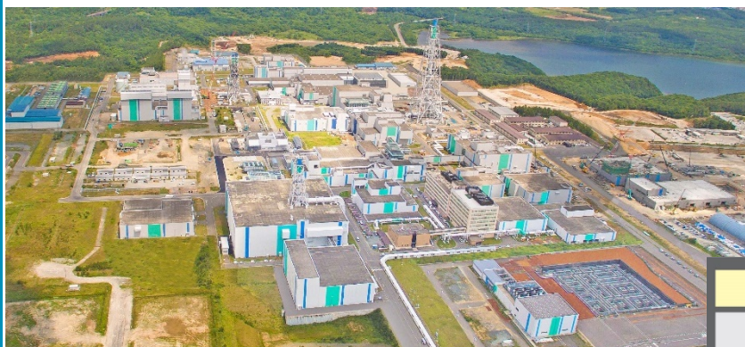
再処理施設 全景
