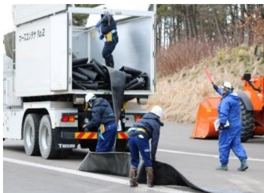
ホース展張作業（建屋外）
