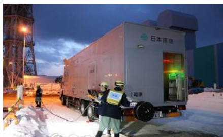
電源車からのケーブル敷設訓練
