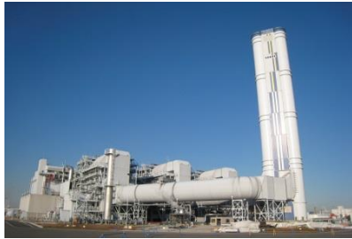
ガスタービン・コンバインドサイクル発電プラント(GTCC)
