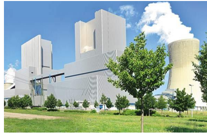
スチームパワー（ボイラー・タービン）発電プラント
