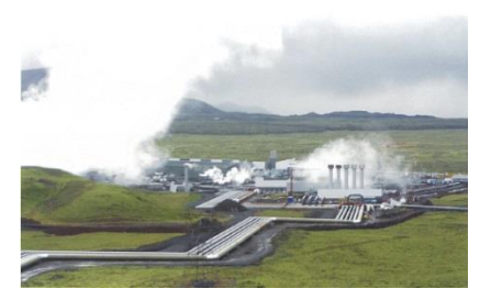
地熱発電プラント
