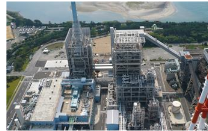
石炭ガス化複合発電プラント (IGCC)
