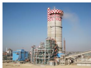
肥料プラント (水素大量製造)
