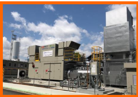
水素CGS エネルギーセンター
