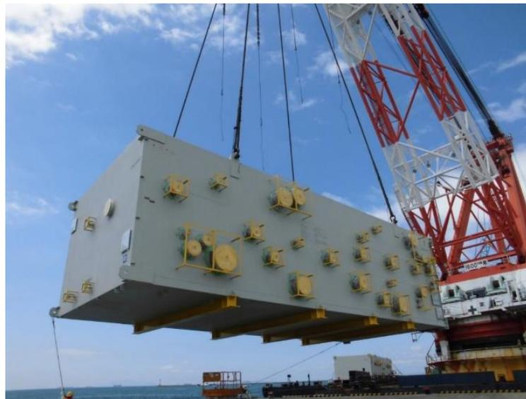
大規模液化向け大型アルミ蝟付けプレートフィン熱交換器
