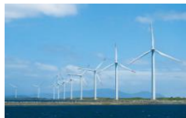
風力発電施設
