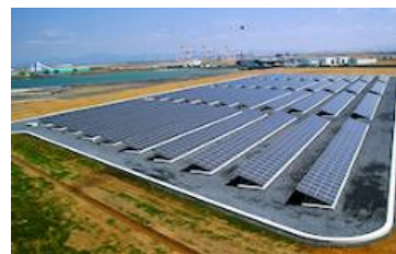
太陽光発電施設
