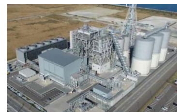
バイオマス発電施設
