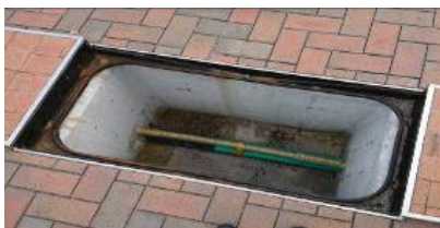
水素パイプライン
