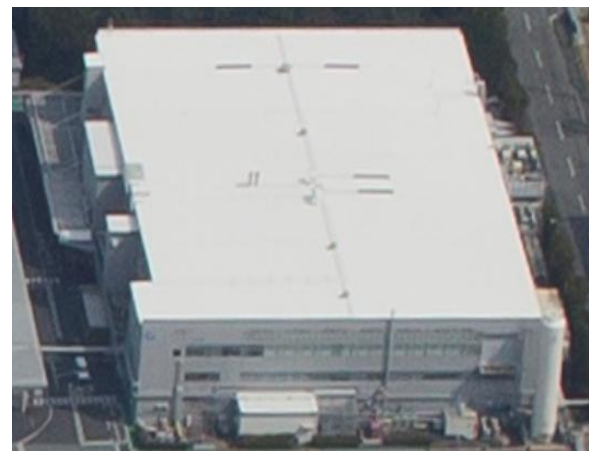
C17棟 燃料電池工場
