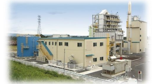
汚泥再生処理施設
