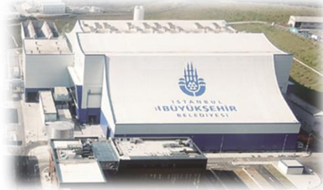
ごみ焼却発電施設
