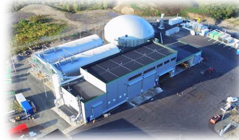
メタン発酵施設
