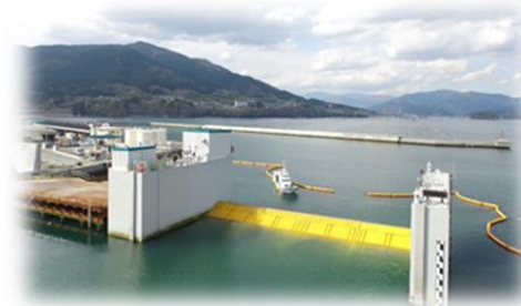
フラップゲート式水害防止装置
