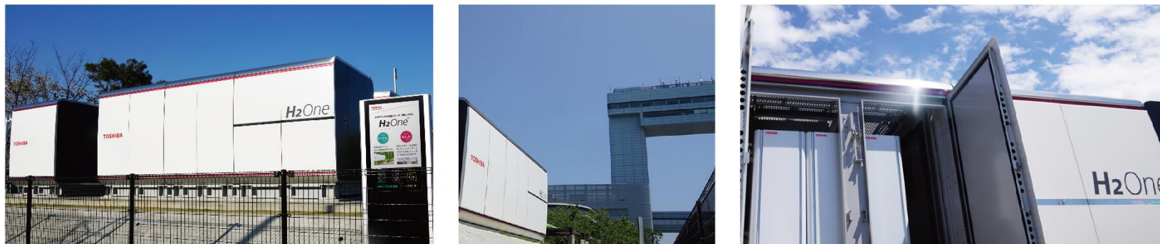
再生可能エネルギーと水素を用いた自立型水素エネルギー供給システム(川崎マリエン)
