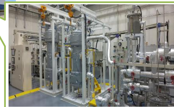
12.5Nm 3 /h級のメタネーション試験装置
