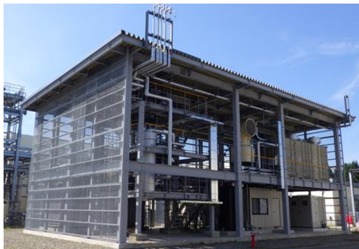
8Nm 3 /h級のメタネーション試験装置
