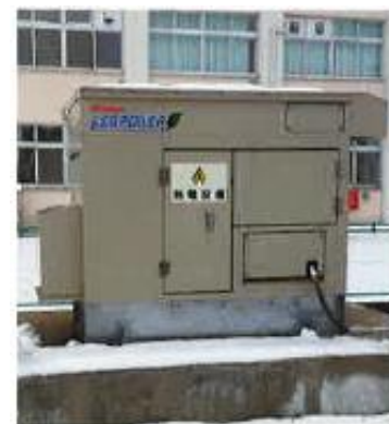
LPガス非常用発電機
