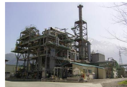
青海工場バイオマス発電設備 (デンカ株式会社)
