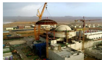
建設中の華龍1号 (110万kW、パキスタン) 60
