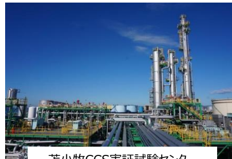
苫小牧CCS実証試験センター
