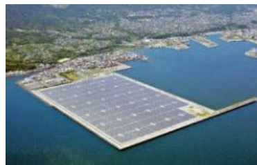
太陽光発電所
