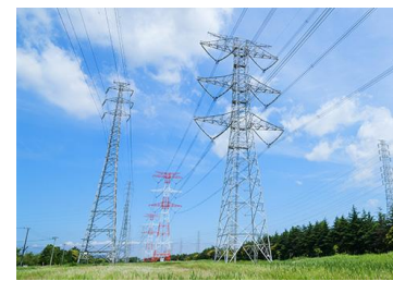
送配電・需給管理
