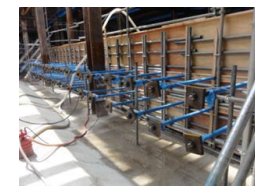
木製型枠を用いた場合
