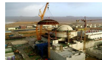
建設中の華龍1号 (110万kW、パキスタン)
