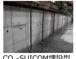
CO 2 -SUICOM埋設型枠を用いた場合
