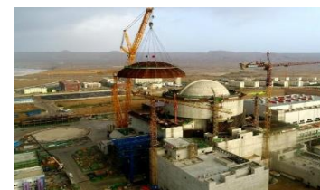
建設中の華龍1号（110万kW、パキスタン）
