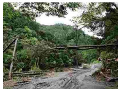
倒木による電線断線→停電
