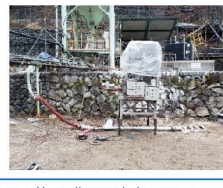
少人数での作業効率向上のため、中和剤貯蔵タンク投入用輸送設備を設置。中和剤20トン（約4週間分）をフレコンバッグで備蓄。また、重量物運搬用のキャリアダンプを配備。
