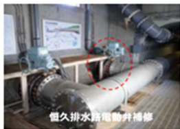
原水送水配管のステンレス化
