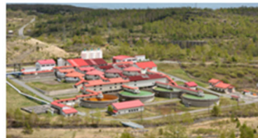
旧松尾鉱山新中和処理施設
