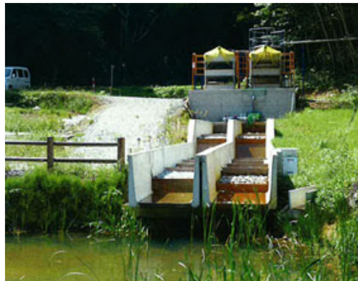
石灰石水路と人工湿地
