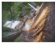
非常用発電機を新設し水中 ポンプによる送水を継続
