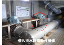
恒久排水路電動弁補修
