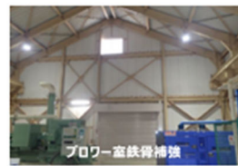
アローウーム鉄骨補強
