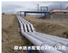
原水送水配管のステンレス化
