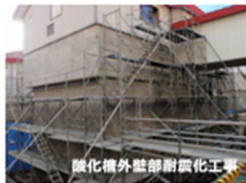
酸化槽外壁部耐震化工事
