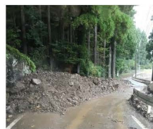
土砂崩れにより道路通行止め
