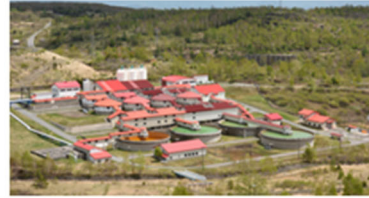
旧松尾鉱山新中和処理施設
