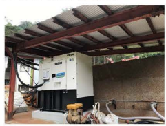
非常用発電機を3台更新、1台新設 （無給油連続運転6時間→41時間 に改善）
