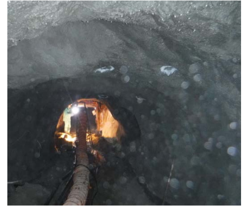
施工後（コンクリ吹付）
