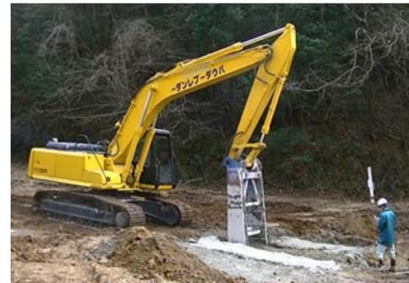
現地における施工試験
