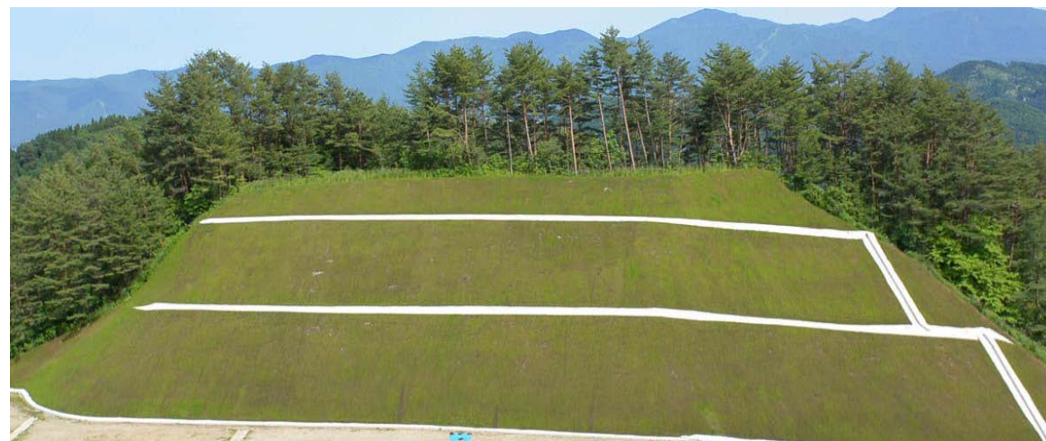
チップクリート緑化工法（被覆後）
