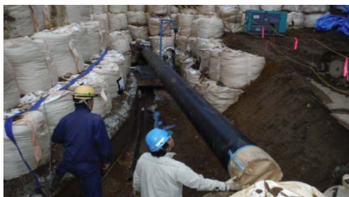
底設暗渠排水管設置(施工中)
