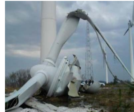
強風により損壊した風力発電設備 (平成25年3月京都府太鼓山)
