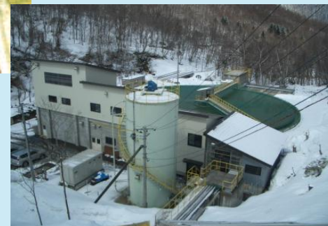
（坑廃水处理施設の例）
