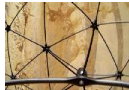
ドローンにより撮影した立坑壁面
