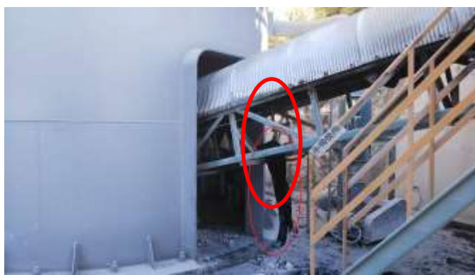
令和元年11月 焼損し溶け落ちた製品排出ベルト
