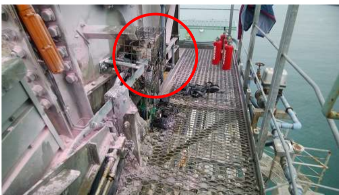
令和元年11月 ベルトコンベアのトリッパーヘッド部
