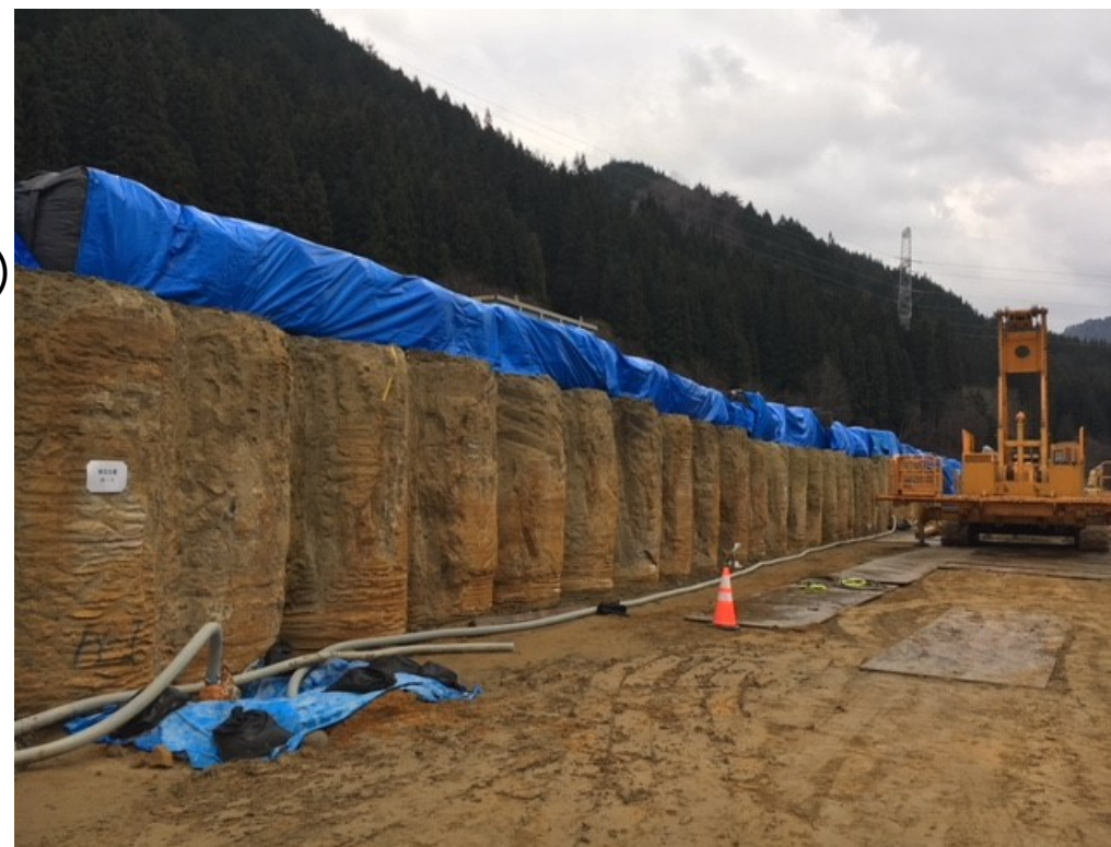
B鉱山安定化工事
