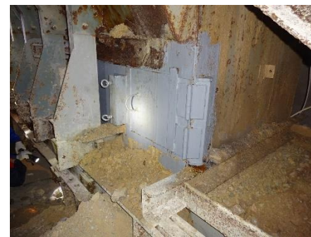
シュート側部に設置した開口部
