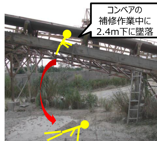
設備からの墜落（令和2年10月） 8
