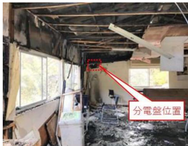
会議室内の分電盤から出火（令和2年4月）
