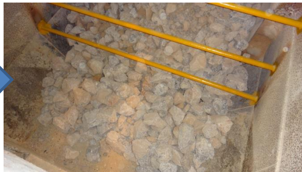
シュート足場に安全柵を設置
