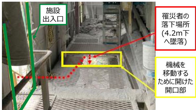
開口部からの墜落（令和2年8月）
