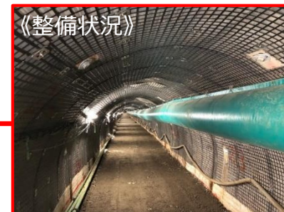
②坑道内整備 (暗渠排水設置、 路面整備)
