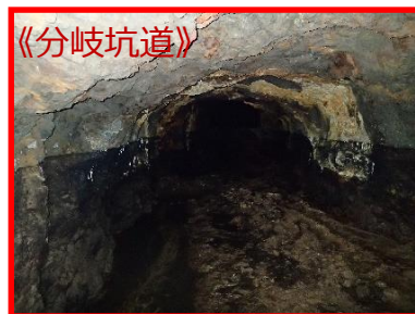
③分岐坑道（一部埋め戻しを実施）
