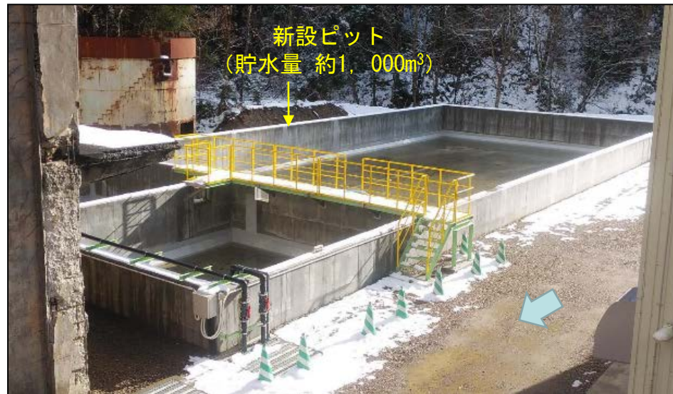
貯水槽全景 (完成後)
