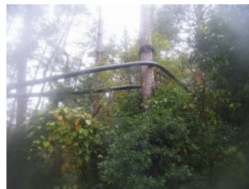
台風豪雨→導水管破損 原水導水管
