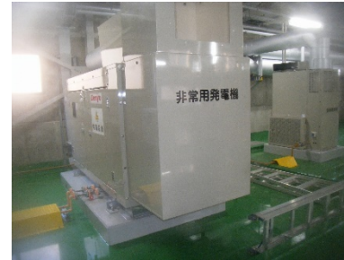
新設 非常用発電機
