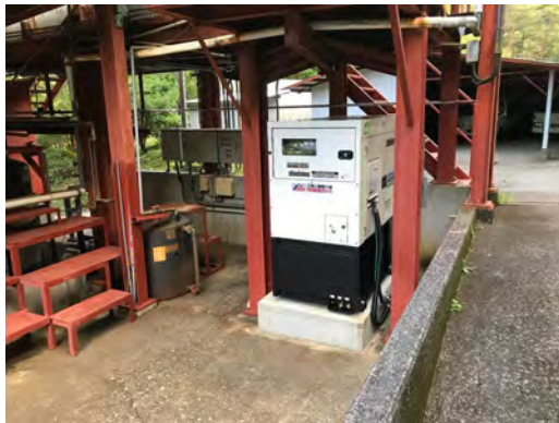
第2処理場（45kVA）
