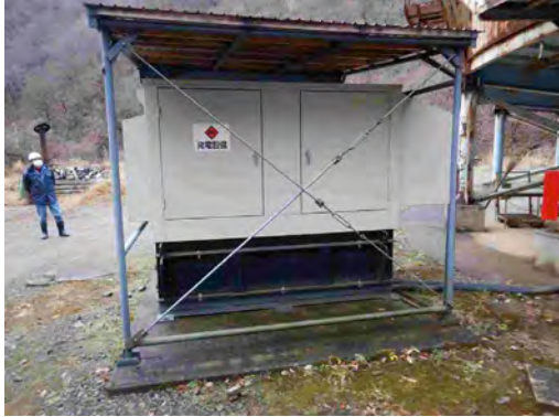
非常用発電機
