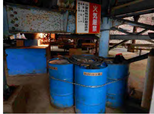
非常用発電機予備燃料
