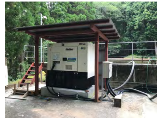
第5処理場（45kVA）
