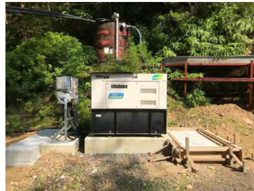
第2堆石場（25kVA）
