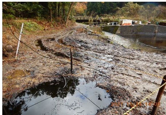
沈砂池への石油流入の状況
