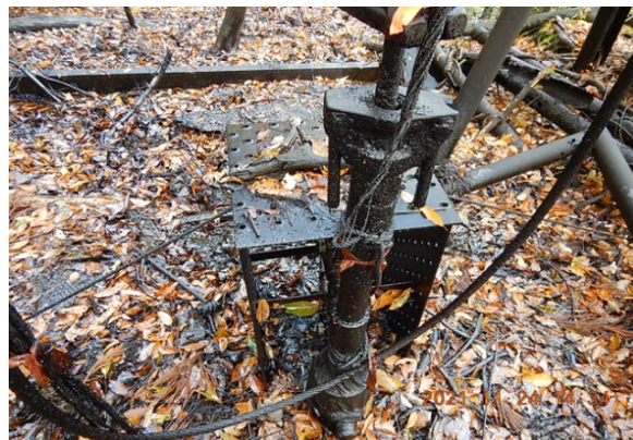
石油坑井の採油装置の状況
