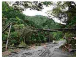
倒木による電線断線→停電
