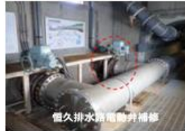
原水送水配管のステンレス化
