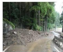
土砂崩れにより道路通行止め
