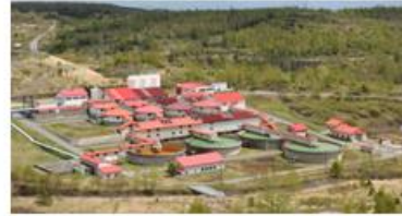
旧松尾鉱山新中和処理施設
