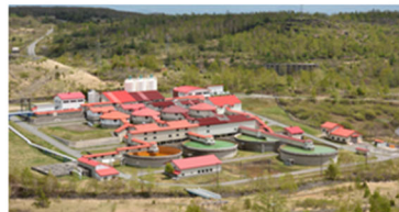
旧松尾鉱山新中和処理施設
