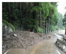
土砂崩れにより道路通行止め
