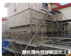
酸化物外壁部耐震化工事
