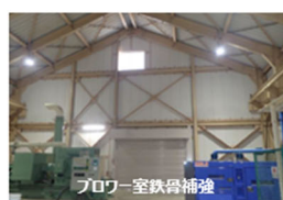
フロー室鉄骨補強
