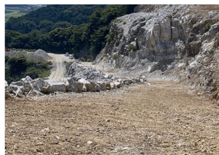
谷側に転落防止設備を設置
