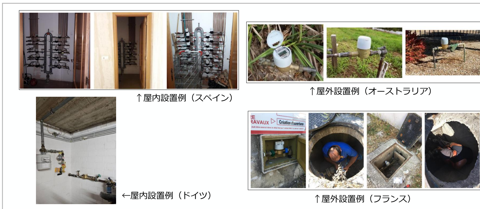
＜欧州の水道メーター設置場所の例＞
