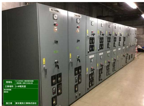
つくばセンター 受変電設備（更新前）
