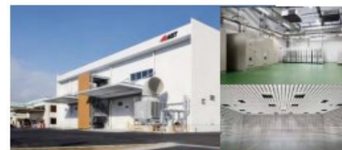
スマートシステム研究棟
