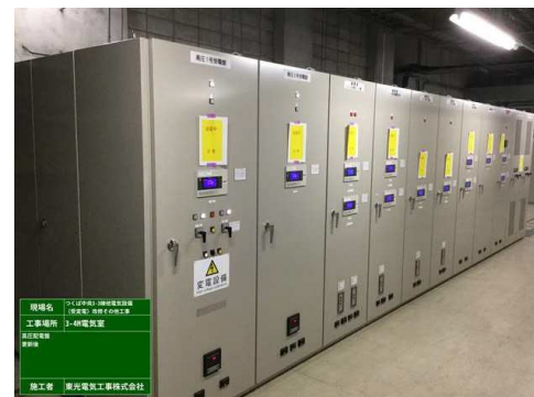
つくばセンター受変電設備（更新後）
