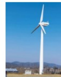
風力発電設備
