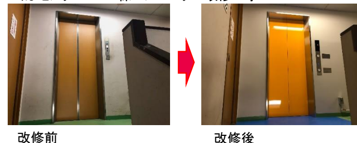
つくばセンター2-4棟エレベーター改修工事
