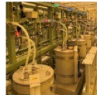
実機サイズのパイロット試験設備：灰洗浄設備の一部（左）とセシウム吸着カラム（右）
