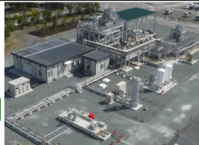
図2. パイロットスケール一貫製造実証設備 全景
