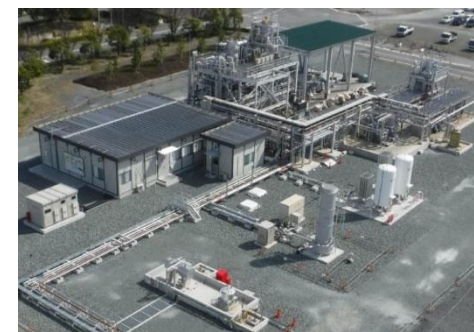
パイロットスケール一貫製造実証設備 全景
