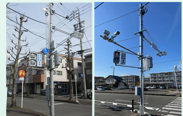
■ AI交通信号機の設置状況
