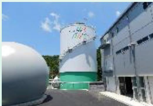
■ 縦型乾式メタン発酵槽
