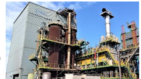
SC50試験高炉（12m 3 ）
