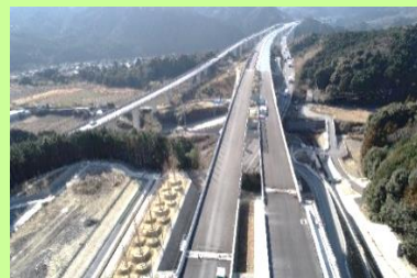
▲ 亀山西JCT（工事当時に撮影）
