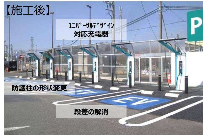
①段差解消②ポール型防護柱③ユニバーサルデザイン対応機器
