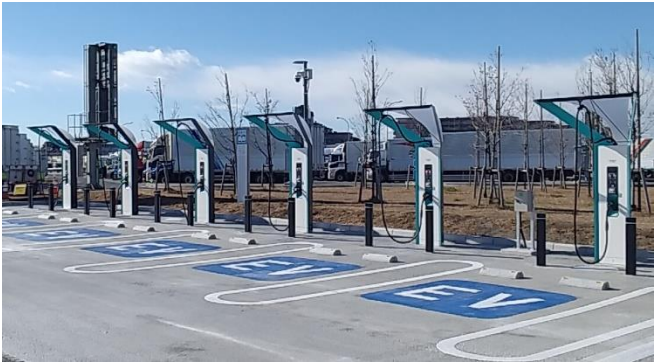
● 東北道 蓮田SA（上） 6口マルチ充電器・1口最大90kW
