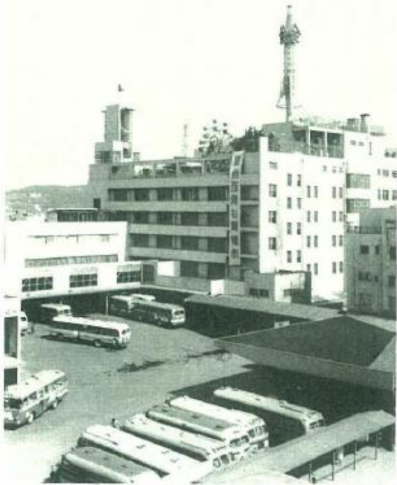
岡山店 再開発工事着工前の岡山店
